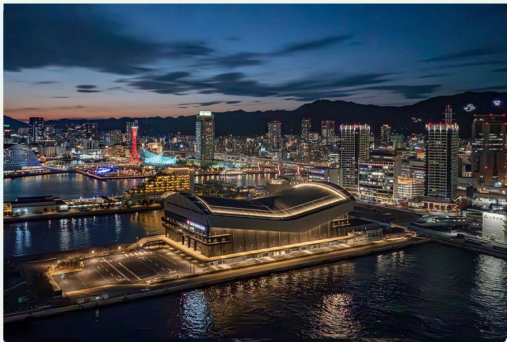
GLION ARENA KOBE（兵庫県）
